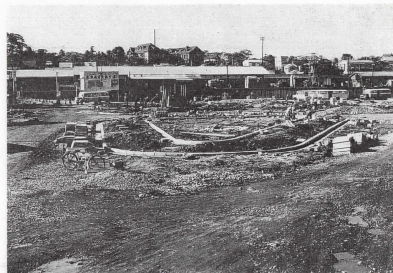
③⑪整備中の大森駅東口広場 昭和27年(1952)
